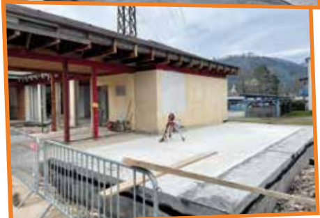
Ein neuer Turnsaal entstand
