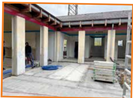
Im Innenhof wird mehr Raum geschaffen
