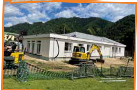
Endspurt bei Wand, Dach und Garten
