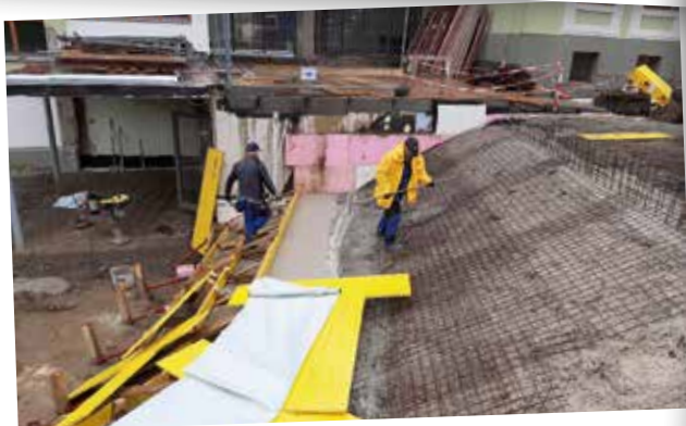
Umbau der Volksschule Pernegg
