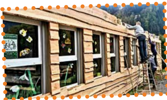
Mit Hilfe unserer Eltern verwandeln wir unseren Container in einen richtigen Fuchsbau. Vielen Dank an die Holzspende vom Fam. Kolland.
